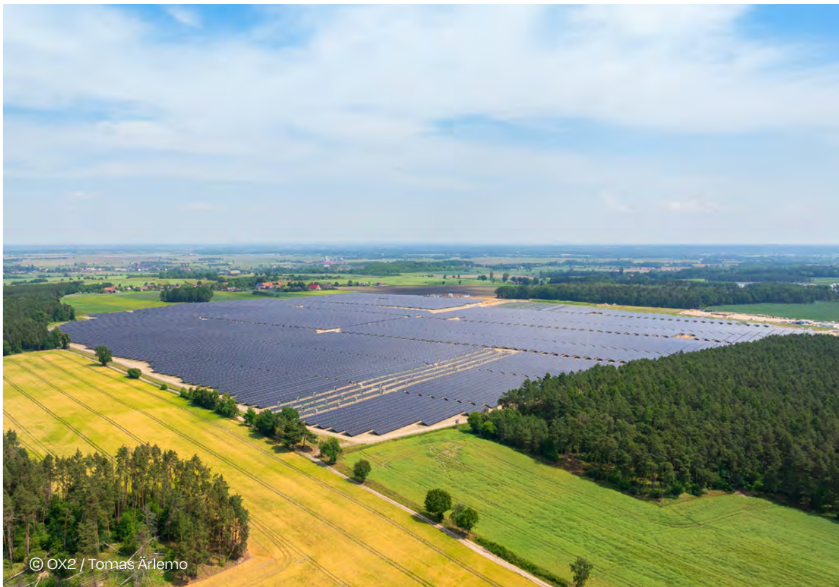
100 MW Rutki solar park, Niemodlin, Poland.
