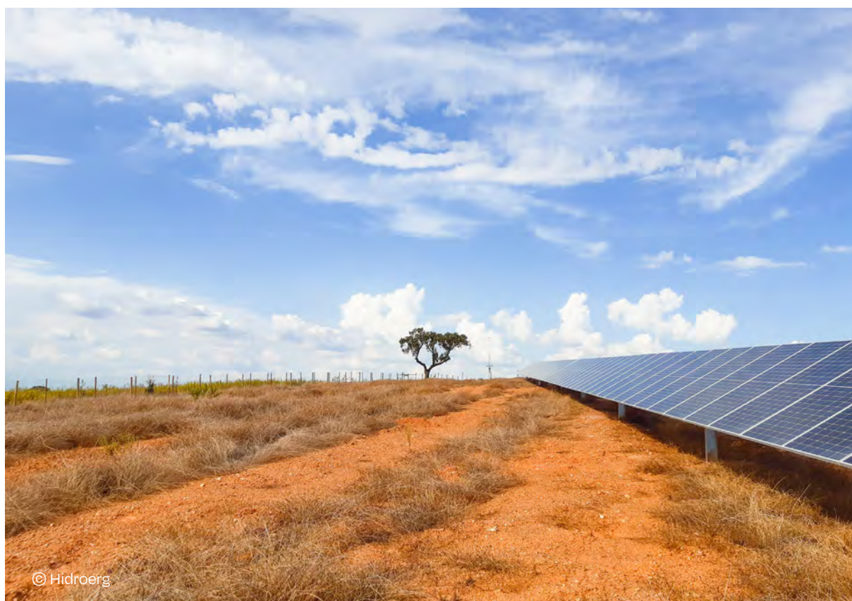
3.5 MW Beja solar PV plant (Hidroerg), Beja, Portugal
