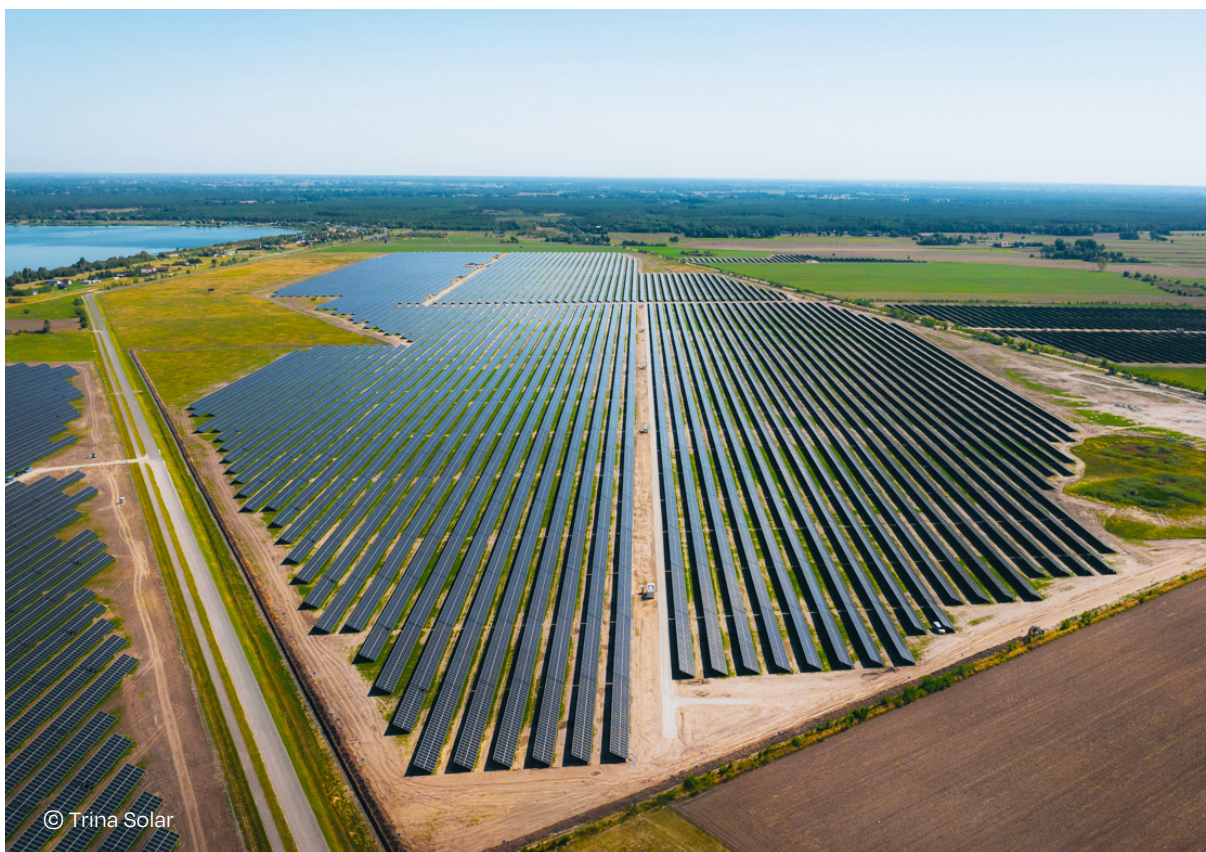
© Trina Solar 200 MW solar plant, Przykona, Poland
