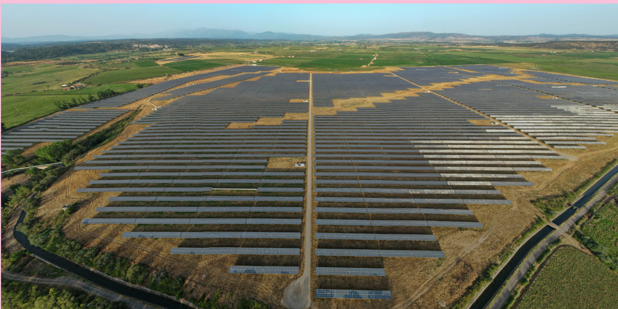
© Sonnedix, Galiesto PV plant.
